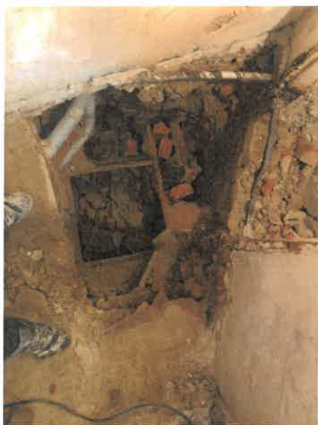
Demolice objektové šachty
