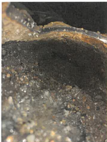
Zanesený průřez potrubí kanalizační přípojky
